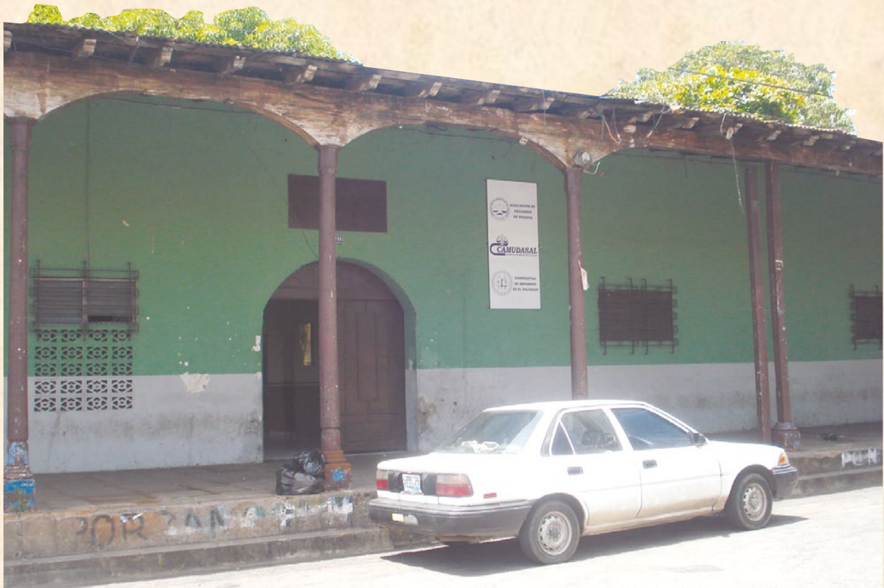
Antiguo local de la Procuraduría Auxiliar de San Miguel ubicado en 8ª Calle Oriente N° 106, "Portal frente a Cancha Álvarez", actualmente oficinas de CAMUDASAL.
