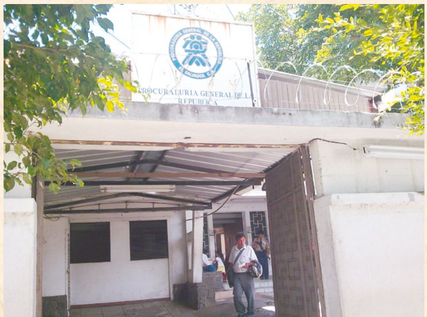
En la actualidad la Procuraduría de Santa Ana está ubicada en Avenida Fray Felipe de Jesús Moraga Norte N° 6.
