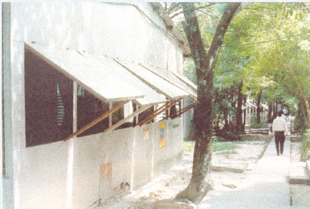
Galeras construidas en el parque infantil a raíz del terremoto de 1986.
